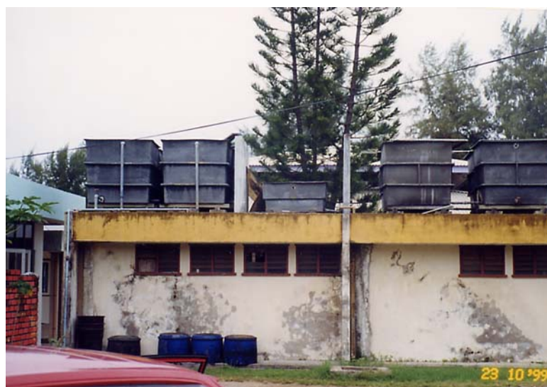
Gambar 20: Tangki air yang tidak bertutup
